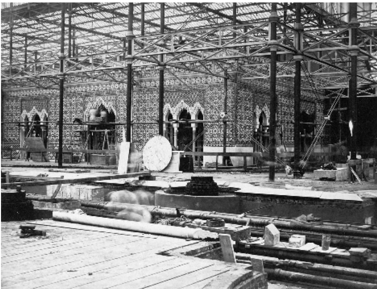
Внешний вид двора Альгамбра во время строительства Фотография Филиппа Анри Деламотта, 1852
