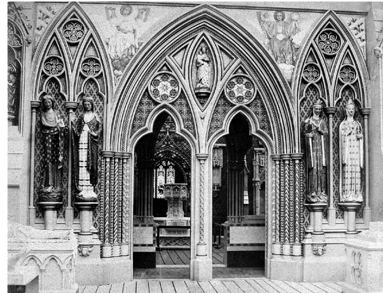
Вход в Средневековый двор, который был перевезен из оригинального Хрустального дворца в Гайд-парке. Он был разработан Огастусом Пьюджином (1812-1852), специалистом по истории средних веков, ярким поборником неоготического стиля и соархитектором Вестминстерского дворца после пожара 1834 года.
